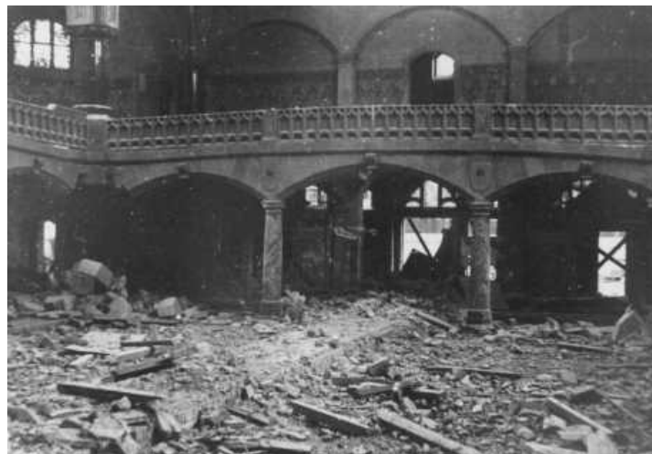
Una sinagoga destrozada durante el pogrom de noviembre en Dortmund, Alemania.
